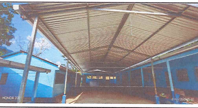
Foto 5: colocacion y cambio de canales fluviales de cuatro modulos
