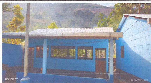
Foto1: cambio total de la estructura del entechado de cocina y colocacion de canalesfluviales
