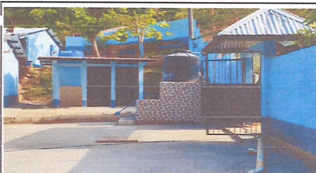
Foto 4: Reparacion de lavamanos
