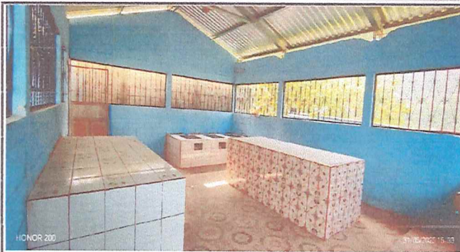
Foto 2: cambio de torta de piso en la cocina y el corredor, piso ceramico, azulejos
