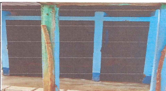
Foto 6: cambio y reparacion de las 3 puertas de los baños
