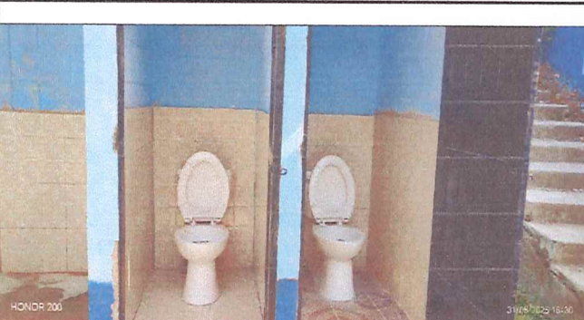
Foto 3: cambio total de los servicios de sanitarios y colocacion de piso ceramico
